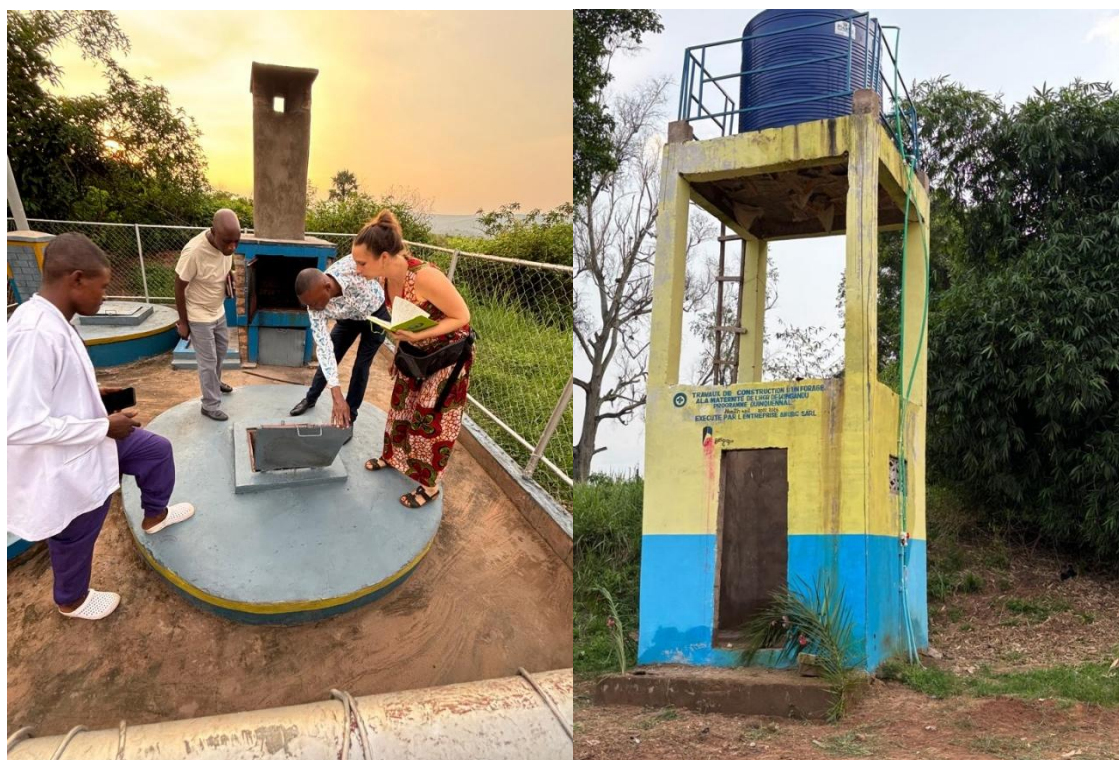
Appui en infrastructure: incinérateurs de déchets biomédicaux et à flacons- forage d'eau HGR Kingandu (Novembre 2024)
