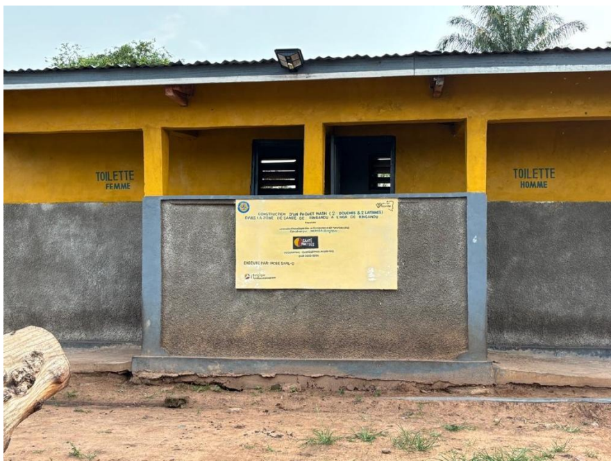
Appui en infrastructure: toilettes des malades HGR Kingandu Novembre 2024
